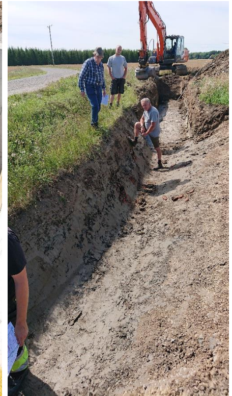
Anläggning av dräneringsförsök år 2018 Foto: Ingrid Wesström
